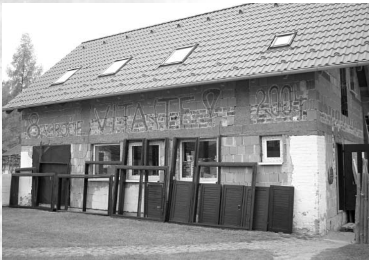
Stolárska dielňa - rekonštrukcia (2002-2006)
