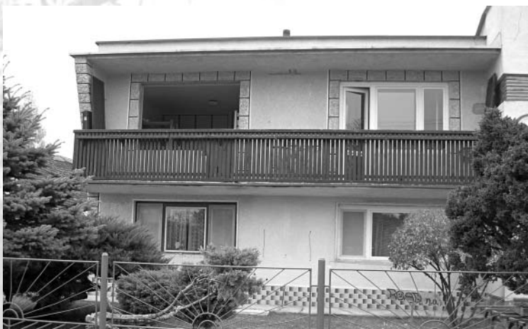
Hlavná budova - výmena okien za plastové (11/2005)
